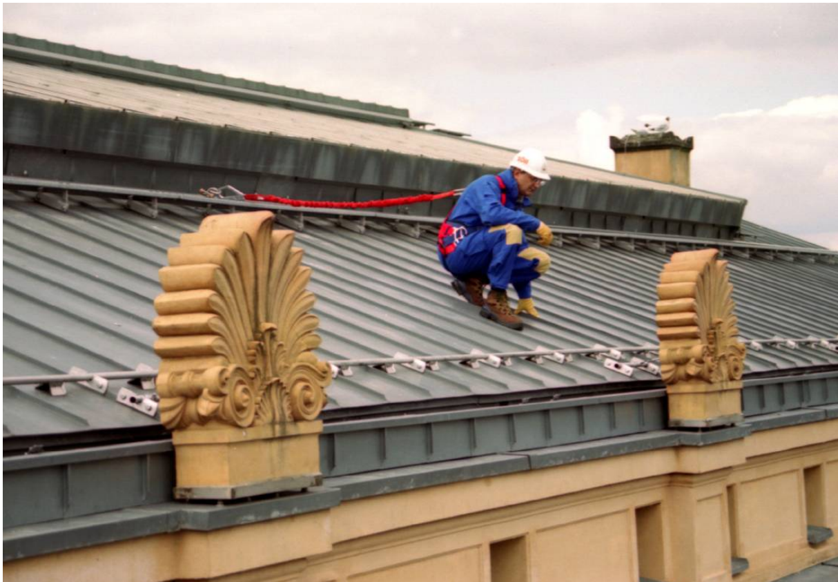
Bild 2: Anschlagseinrichtung mit einer horizontalen Führungsschiene und beweglichem Anschlagpunkt – Quelle: Fa. Sperian
