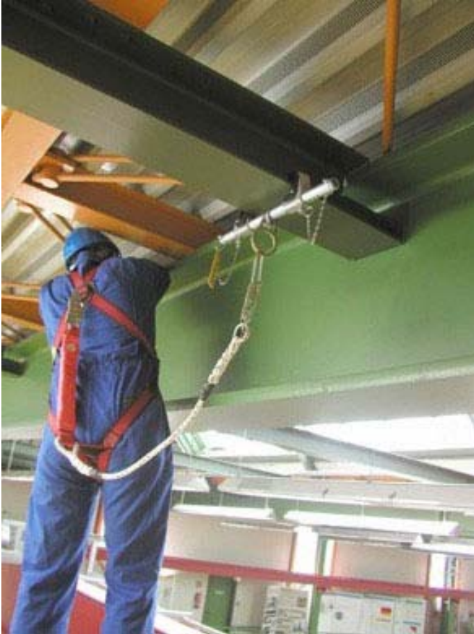
Bild 6: Beispiel für eine temporäre Anschlagseinrichtung – Trägerklemme, Quelle: Fa. BH Sala
