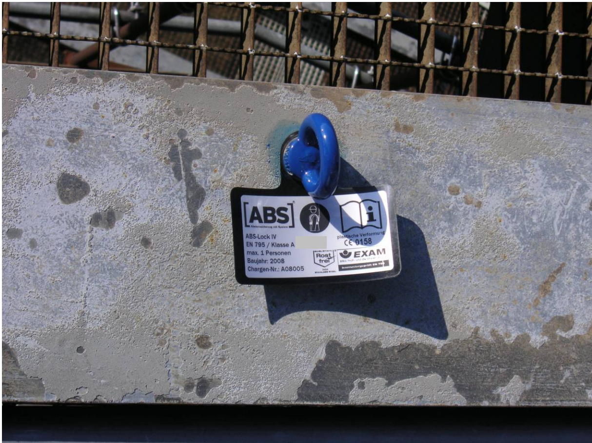
Bild 3: Beispiel einer Anschlageinrichtung mit CE-Kennzeichnung
