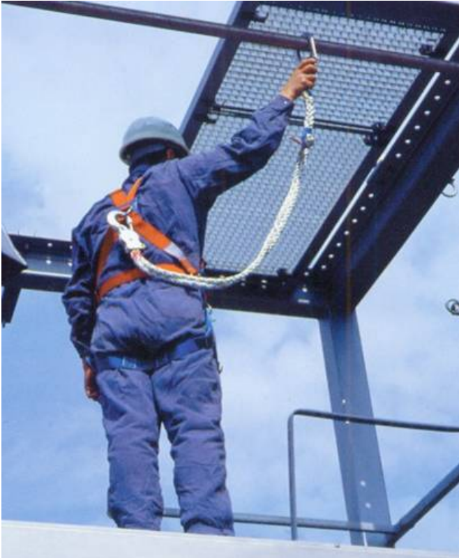
Bild 12: Beispiel für eine Anschlagmöglichkeit am Bauwerk/an einer Konstruktion - Rohr
